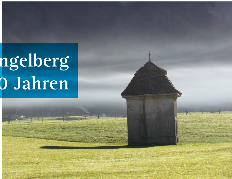
Das Pumphäuschen im Sood. Die insgesamt sechs Pumphäuschen nahmen im Dezember 1919 ihren Betrieb für das EWLE auf (Foto: Pia Hess).
