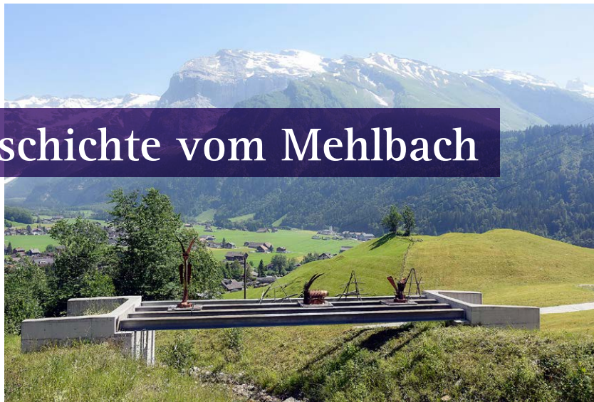
Die Stahlbrücke über den Mehlbach mit allen Akteuren.
