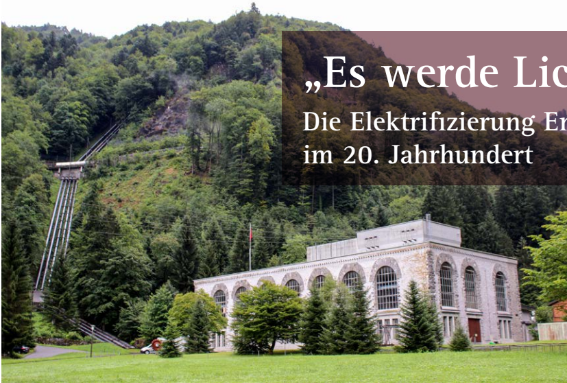
Das Kraftwerk Obermatt, das seit 1905 Engelberg mit Strom versorgt (Foto: Mike Bacher).
